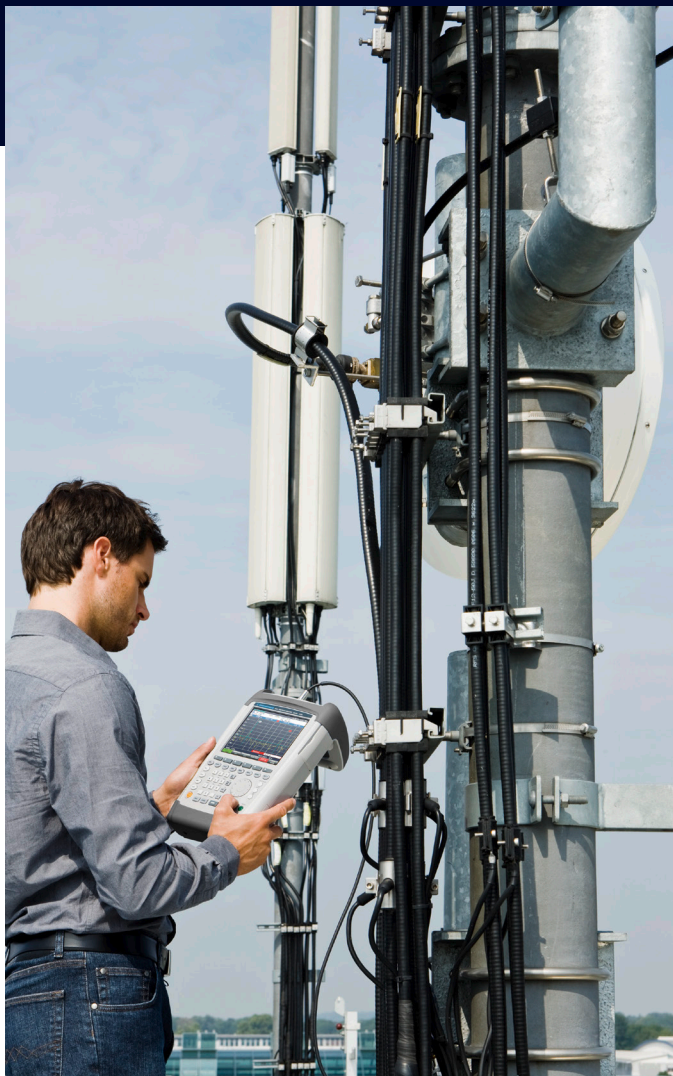
Измерение расстояния до места повреждения в антенной системе для мобильной радиосвязи с помощью R&S®ZVH
